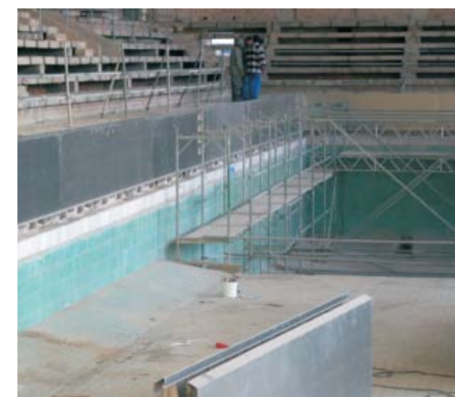
При реконструкции стенки бассейна опираются на существующий бетонный каркас
