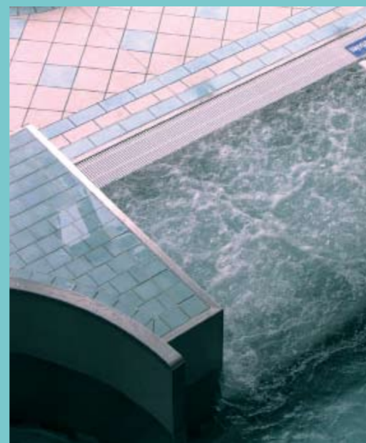
На фото: Устройство волновых бассейнов из нержавеющей стали, каналов течения, массажных дюз
