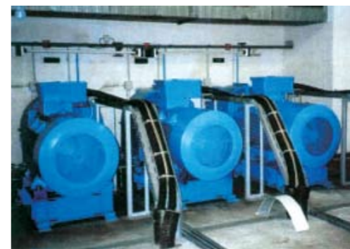
На фото: аксиальные насосы в гидроканале для каноэ
